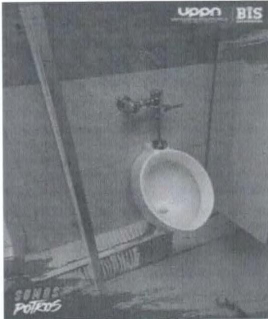
Se llevó a cabo la reparación de línea de desagüe e instalación de un nuevo mingitorio en sanitarios del edificio A
